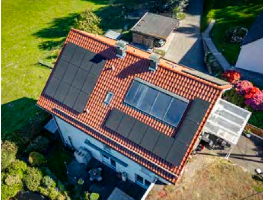
Die Fachleute der Stadtwerke Witten haben beide Dachseiten mit Modulen belegt. So nutzen die Höpkens die Sonnenstrahlen den ganzen Tag über.
